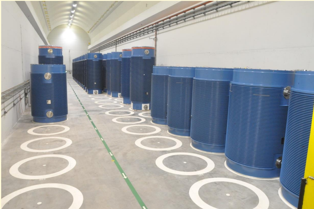
Innenansicht des Standortzwischenlagers Neckarwestheim
