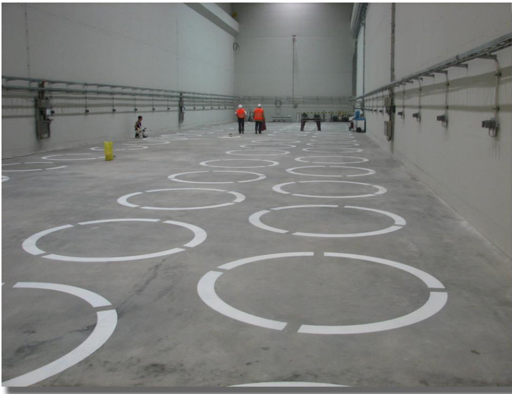
Zwischenlager Neckarwestheim vor der Einlagerung von Castor-Behältern im Jahr 2006 – Tunnelröhre (mit Stellplatzmarkierungen)
