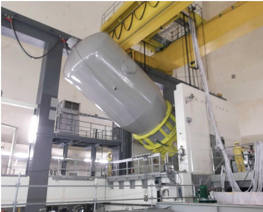
Abbau eines Dampferzeugers im Kernkraftwerk Obrigheim im Rahmen der 2. SAG
