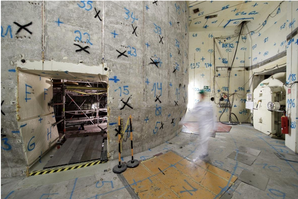
Reaktorgebäude des sich im fortgeschrittenen Rückbau befindlichen MZFR (Markierungen an den Gebäudestrukturen rühren aus Messungen zum Zweck der Freigabe her)
